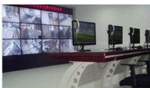
天网/雪亮工程/集团公司监控集中管理
